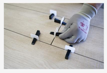
Se desaconseja la colocación a junta trabada mayor del 25% para evitar la aparición de cejas. No se aceptarán reclamaciones de material colocado a junta trabada mayor del 25%
